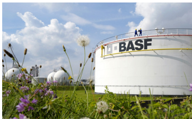
La foto muestra uno de los diversos tanques que suministran materias primas a las instalaciones de producción en Ludwigshafen (Alemania).
